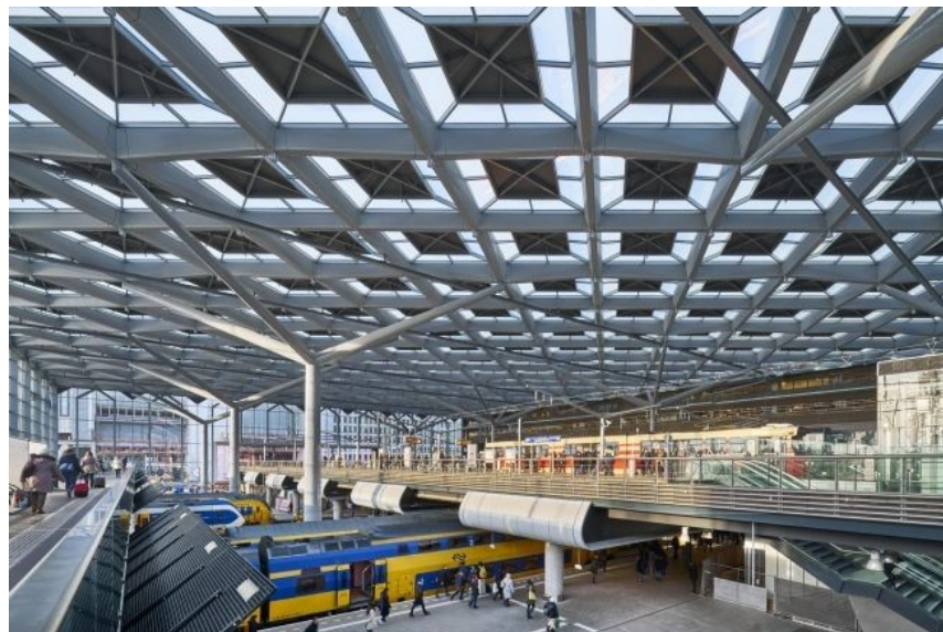
Рисунок 17 - Вид на навесную плиту вокзала [9].
